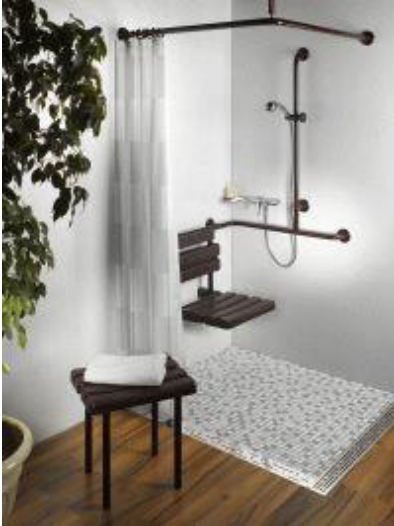
Bild 25: Dusche mit senkrechten und waagerechten Haltegriffen (sowie Duschsitz).
